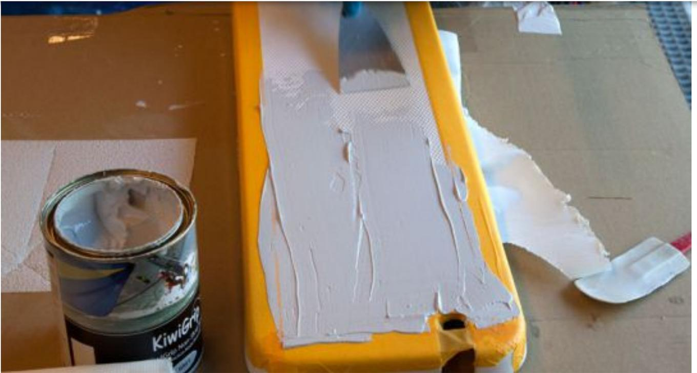
Le Kiwi Grip se dépose de façon uniforme à la spatule. Appliquez-vous à réaliser quelque couche uniforme. Prenez votre temps, le produit ne sèche pas rapidement.
